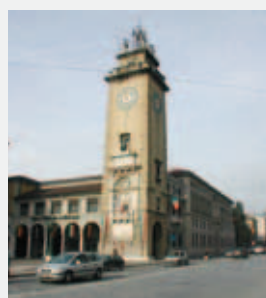
La Torre dei Caduti (Bergamo) restaurata con il contributo della Fondazione Banca Popolare di Bergamo Onlus
