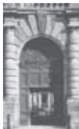
2. Roma Particolare della facciata di Villa Giulia
