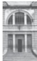
23. Potenza Particolare della Scuola Industriale
