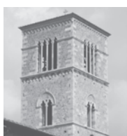
16. Terni Campanile della Chiesa di San Francesco
